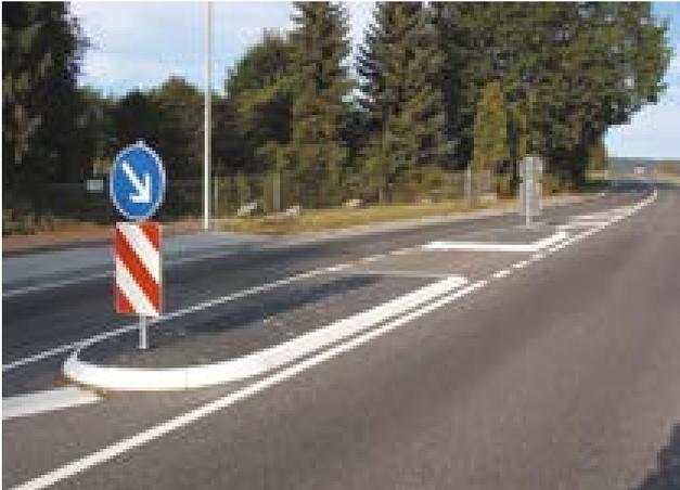
Mit SILIKAL® Mörtel R 17 auf Asphalt geklebte Flachborde für eine Fußgängerüberquerung
