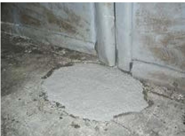
Ausbesserung der Bodenflächen in einem Tiefkühlhaus bei laufendem Betrieb mit SILIKAL® Mörtel R 17 (-25 °C)
